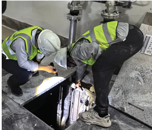
青年突击队队员检查水泵和集水井。
