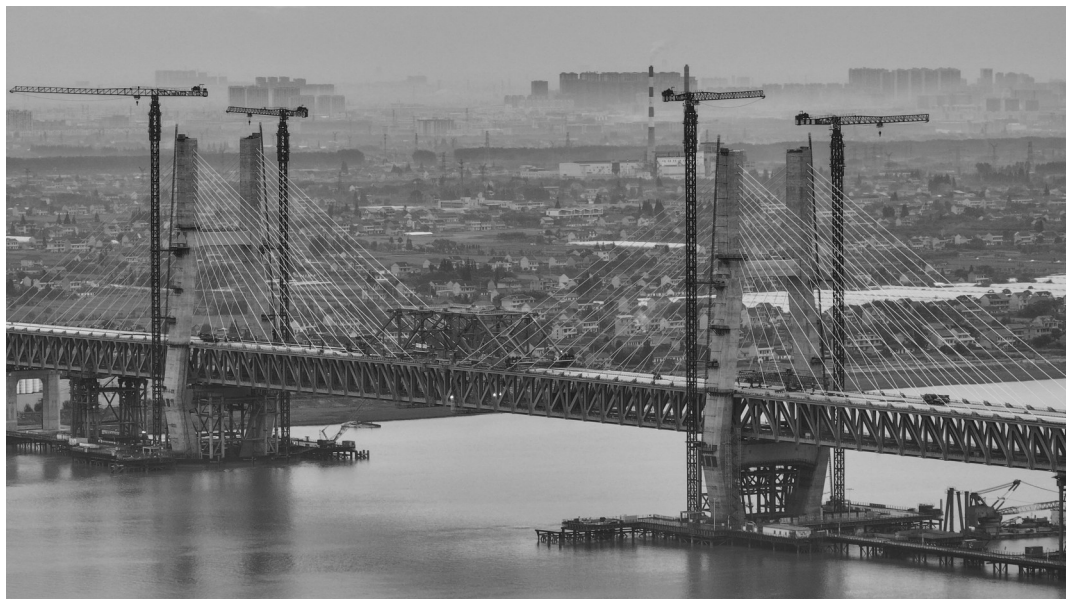
崇启公铁长江大桥。
