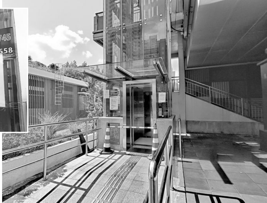
恒丰路桥电梯的电梯门开着,却被路障拦住。
