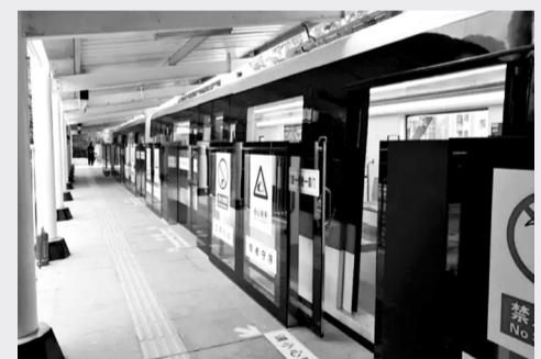
向架及车钩装置。站台以地铁车站站台为原型，建设37米长、1.2米高混凝土平台，站台上安装有雨棚及屏蔽门等设备。轨道线路长约100米，其中包括36米检修地沟，16米有砟道床，一组7号道岔，其余为整体道床。
