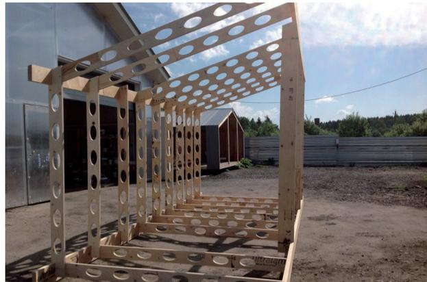
相比于普通的住宅, DD16的所有结构部件和内部装饰均能够根据使用需求进行调整。建筑的框架由带有卡口的层压木材构成, 能够帮助降低结构的重量并减少热传导现象的出现。
