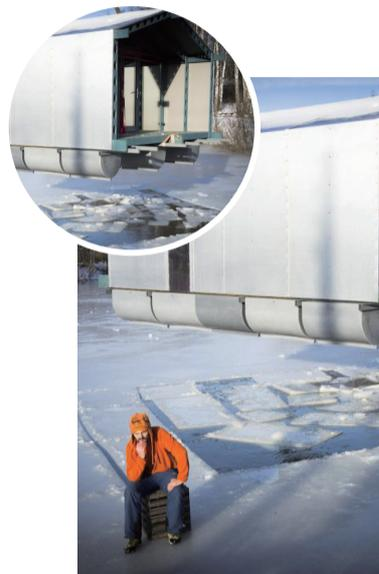
隐藏在下方的模块化浮筒与房屋的框架是同时制作的, 因此可以使房屋直接漂浮在水上。房间内运用了各种自动化系统, 包括太阳能发电、湖水再利用和生态厕所等。
