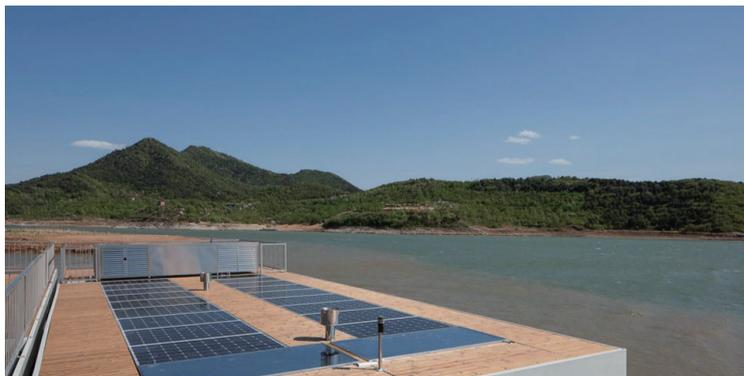
FloatWing能自发产生它所需要的所有能量, 大部分能量直接来自太阳。它利用对环境影响较少的材料和技术生产, 以减少碳排放量, 降低能源需求。例如, 它所有的外部墙壁、地板和天花板都使用宽10厘米的ICB木栓保温层, 并使用双层或三层加氩气或氮气玻璃窗, 这样使它的室内温度即使在最极端的气候下也可以保持在20到25摄氏度。
