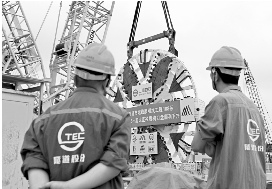
轨道交通崇明线108标进行刀盘吊装下井。
