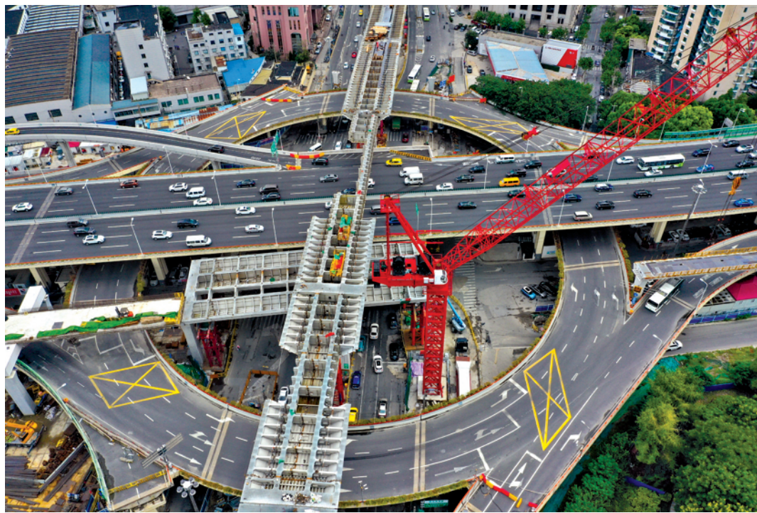
三跨一联、长168米、总重1475吨的钢箱梁,在距离地面30米的上空成功合龙。 特约摄影 张海峰、刘秀国
