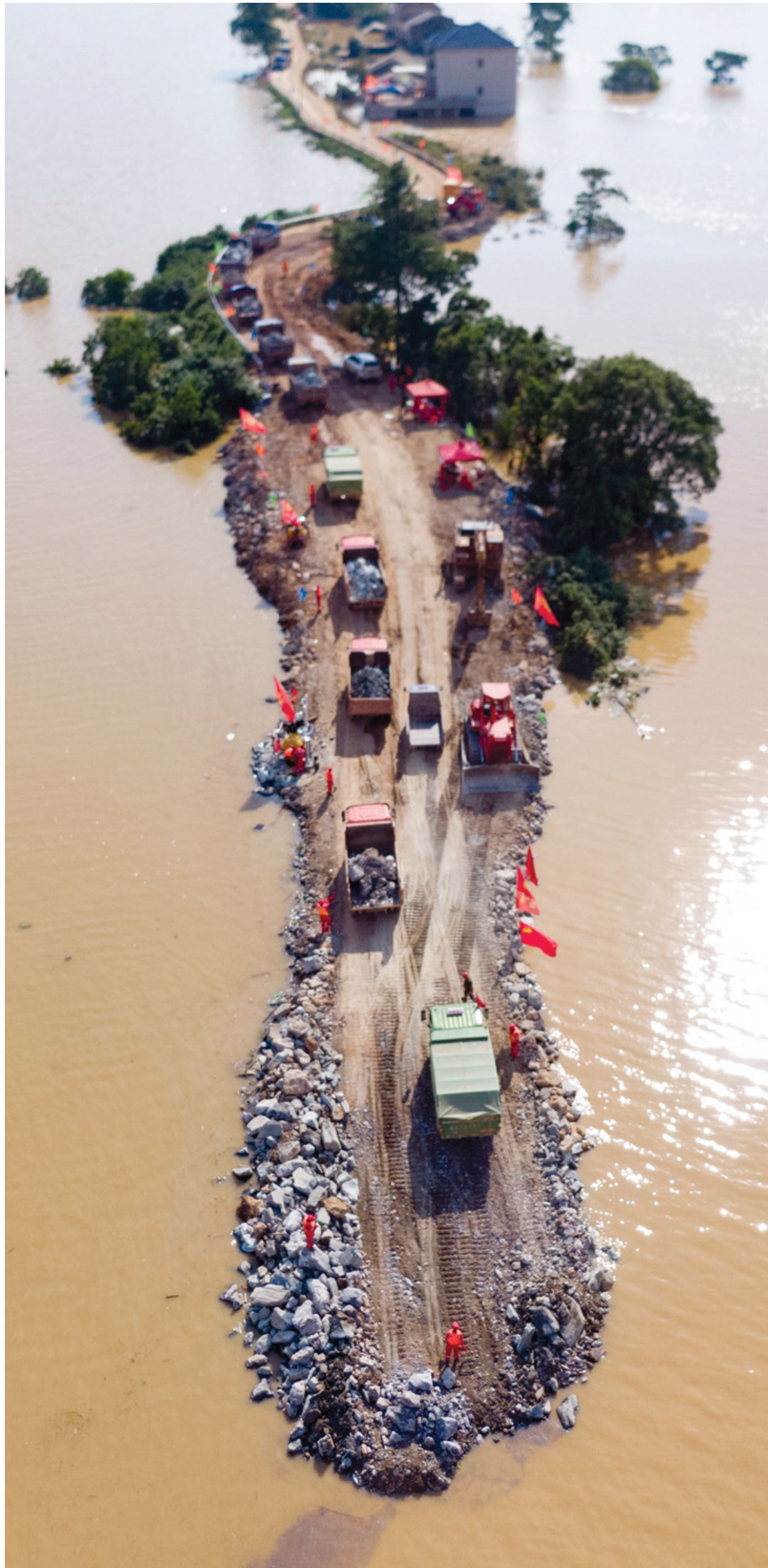
江西省鄱阳县鄱阳镇问桂道圩堤抢险施工现场。
