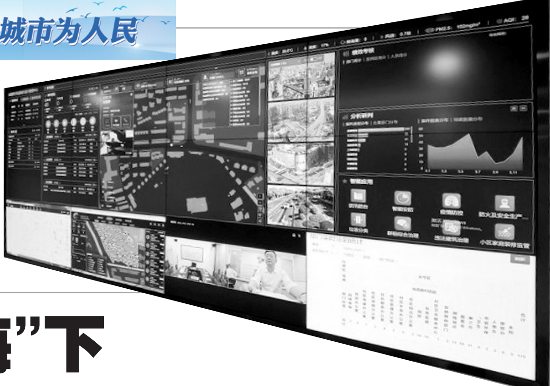
▲防汛指挥大屏2.0聚焦信息数据集成与实战应用展示，围绕积水防治和台风防御等应用场景，着力实现智慧模块互联互通，强化值班值守、预警发布、灾情报送等业务模块智能应用，不断提升防汛指挥调度智能化水平。 受访者供图
