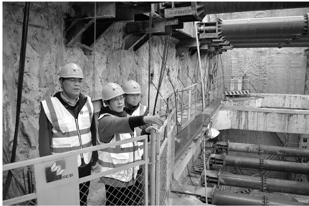
许丽萍(中)勘察施工现场。
