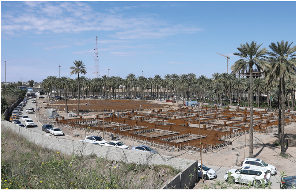
这是2019年3月19日在伊拉克巴格达拍摄的正在建设的高档酒店。
