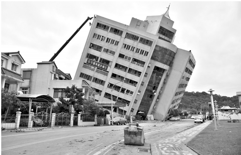
这是倾斜倒塌的云门翠堤大楼。
