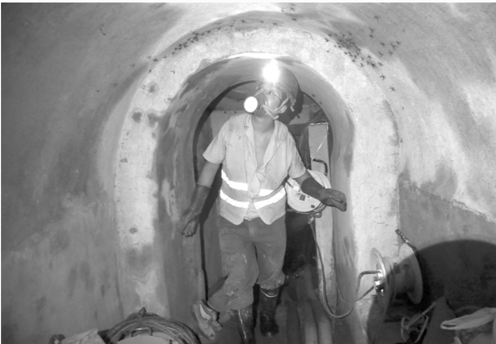
施工人员正在勘查防空洞。
