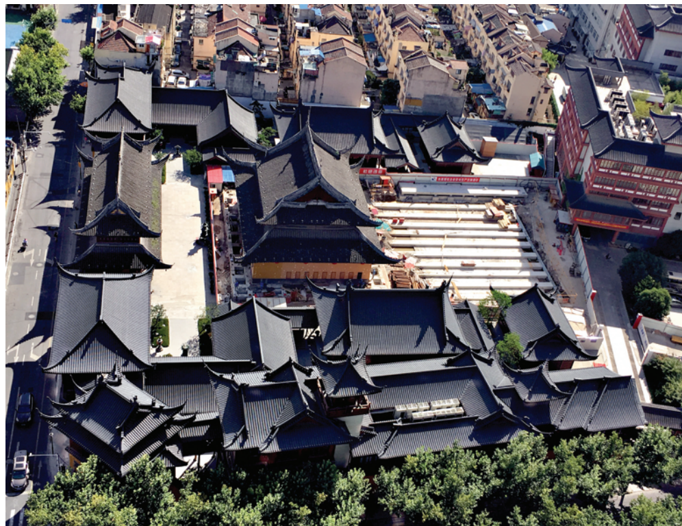
玉佛寺大殿将向北位移30.66米,到位后顶升1.05米。
