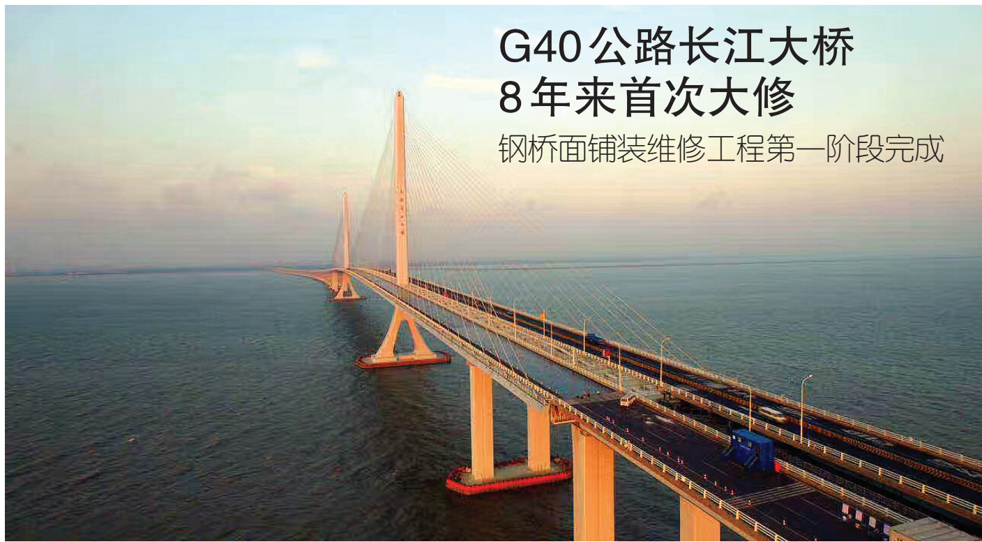
维修中的长江大桥。
