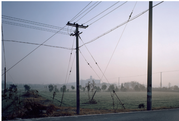
每一个大后方都很常见的基础设施，组成了该地区之后发展的框架。
