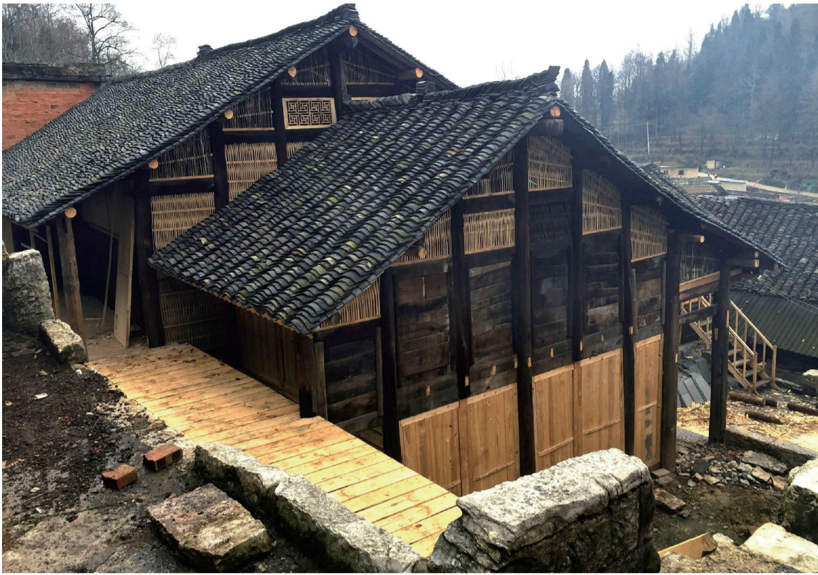
贵州房屋修复后
