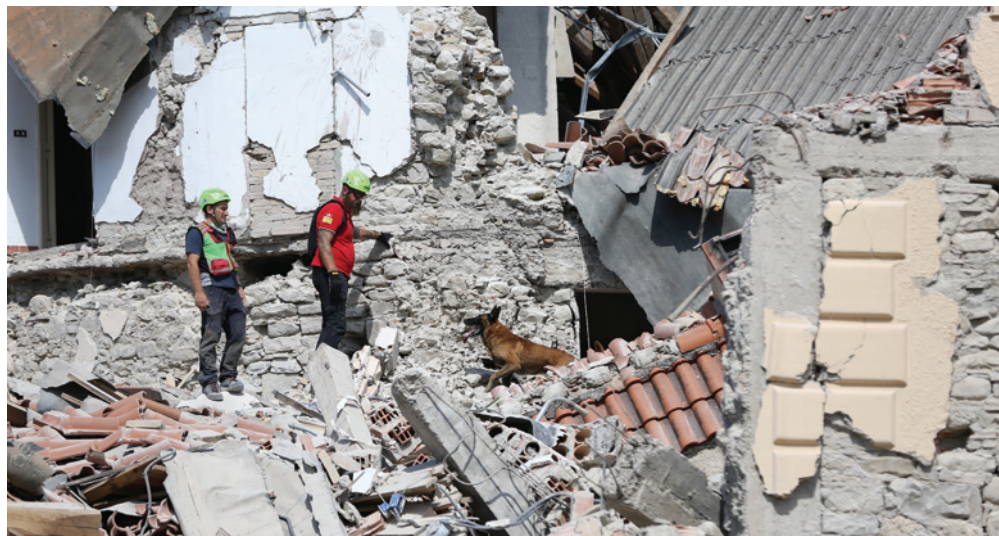
意搜救人员和搜救犬在一处倒塌房屋废墟中搜救。
