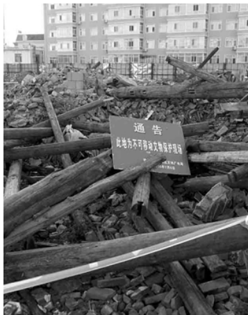
左图：被损毁的刘亚楼旧居。
