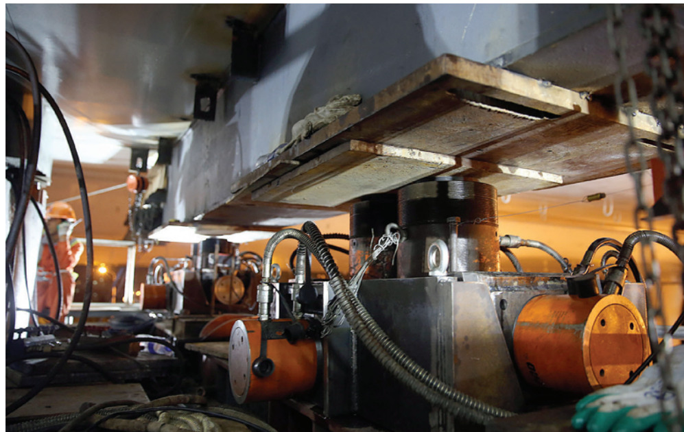
中环抢修实施梁体顶升。
