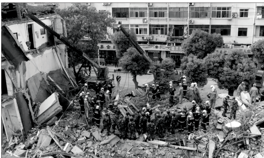
事故发生后,多部门现场展开救援。
