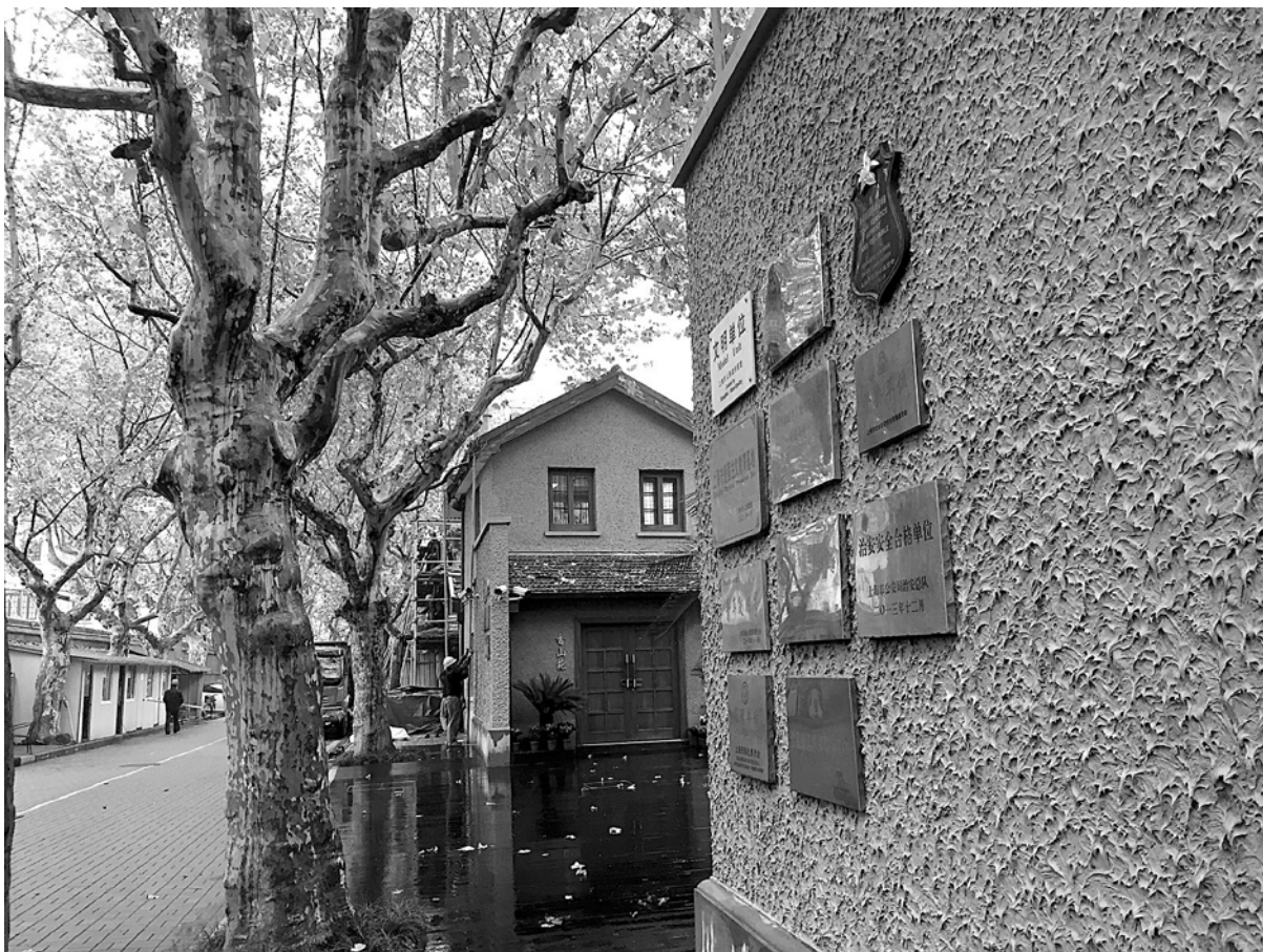
上海孙中山故居正在进行整体修缮。
