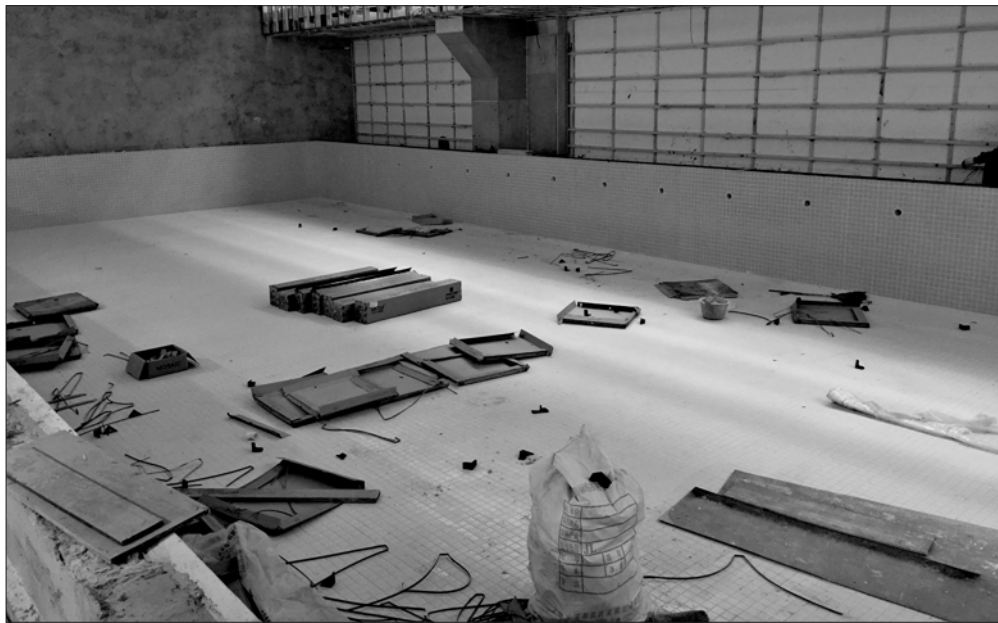
健身房还未装修完毕,地面上一片狼藉。
