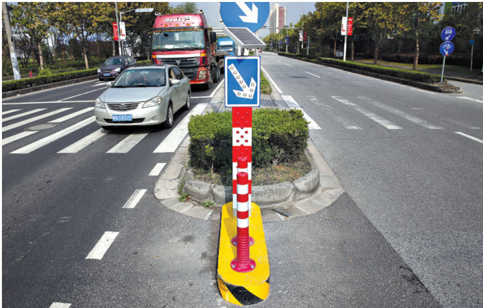
位于水产路、杨泰路路口的组合式太阳能警示柱。
