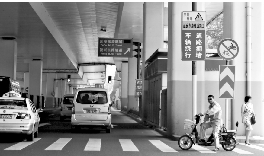
延东隧道南北交换施工首个工作日，不少车辆走错道。
