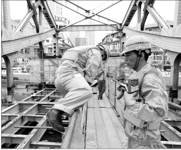
移桥工作人员在施工。 青年报记者 施培琦 摄
