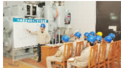
在智能变电站里开展技能培训。
