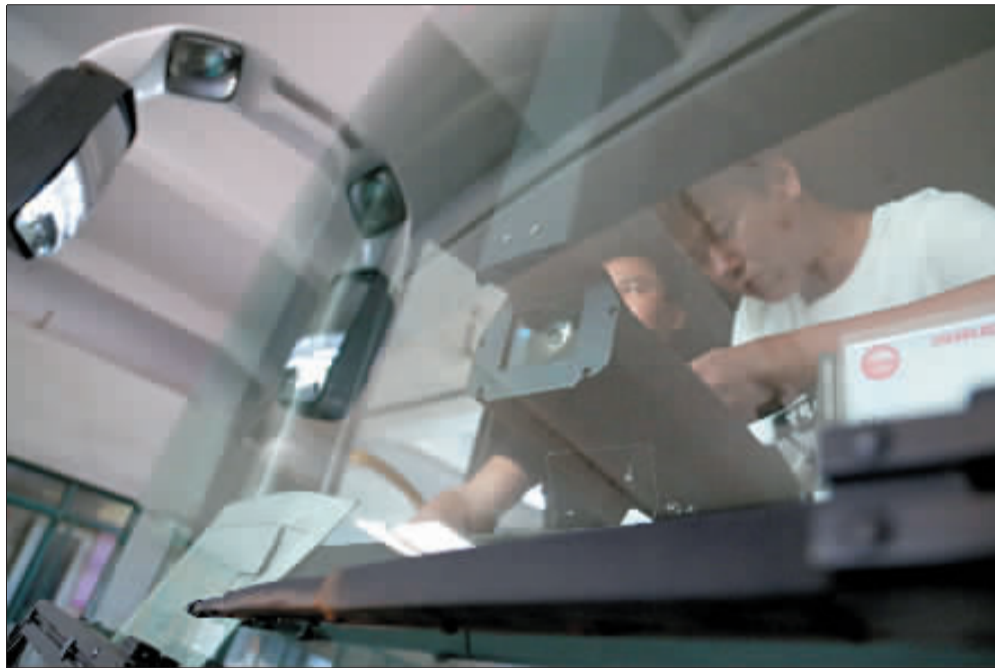
工作人员正在为公交43路安装监视器。
