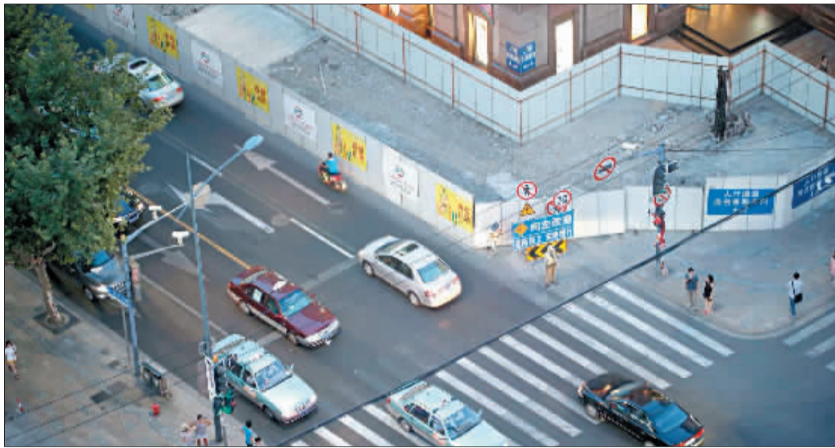
淮海路“白改黑”工程已顺利竣工。
