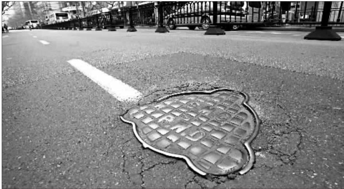
北京西路上的窨井盖。
