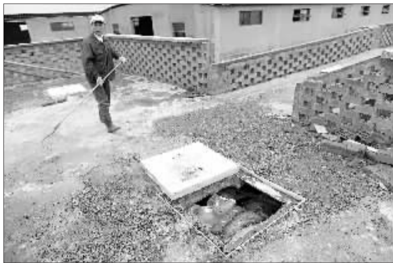
位于嘉兴市南湖区新丰镇横港村的一处病死猪无害化处理池埋有近5000头死猪，近期仍不断有新的死猪被填入。 本报记者 张瑞麒 摄
