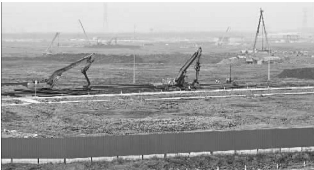
迪士尼项目正在建设中。
