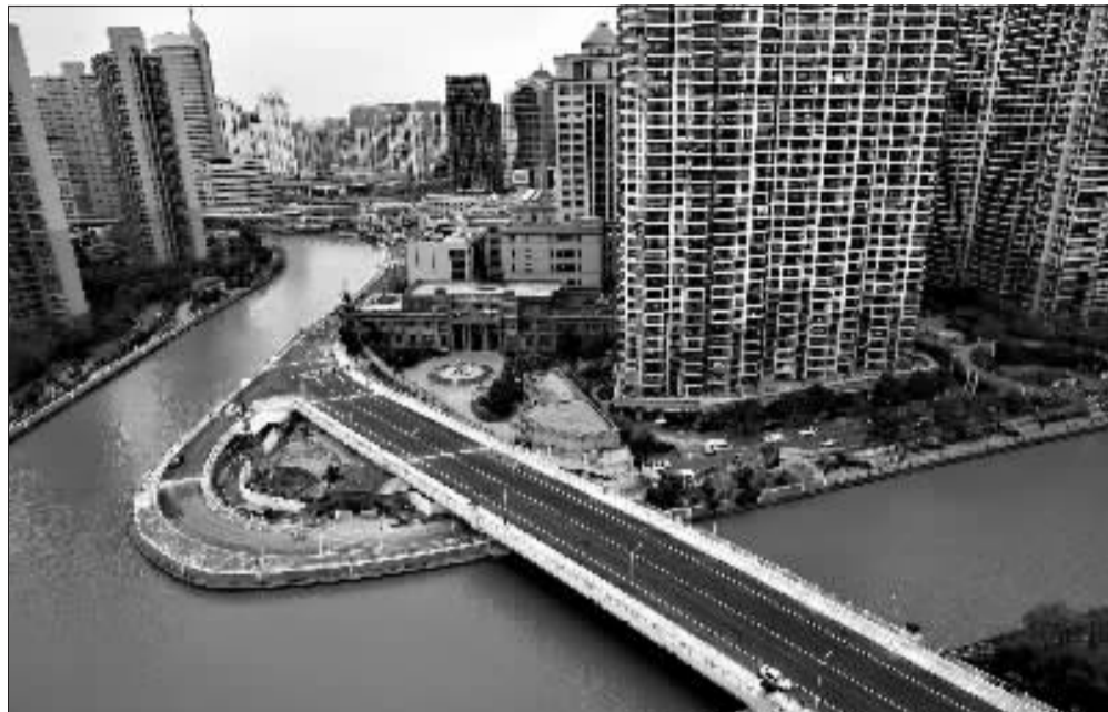
江宁路桥桥面明显拓宽。
