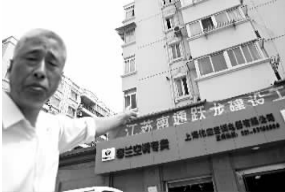
冯先生对于违章搭建的雨棚十分不满,雨棚可能威胁到冯先生家里的住房安全。
