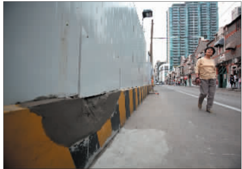
事故损坏墙面已经修复。
