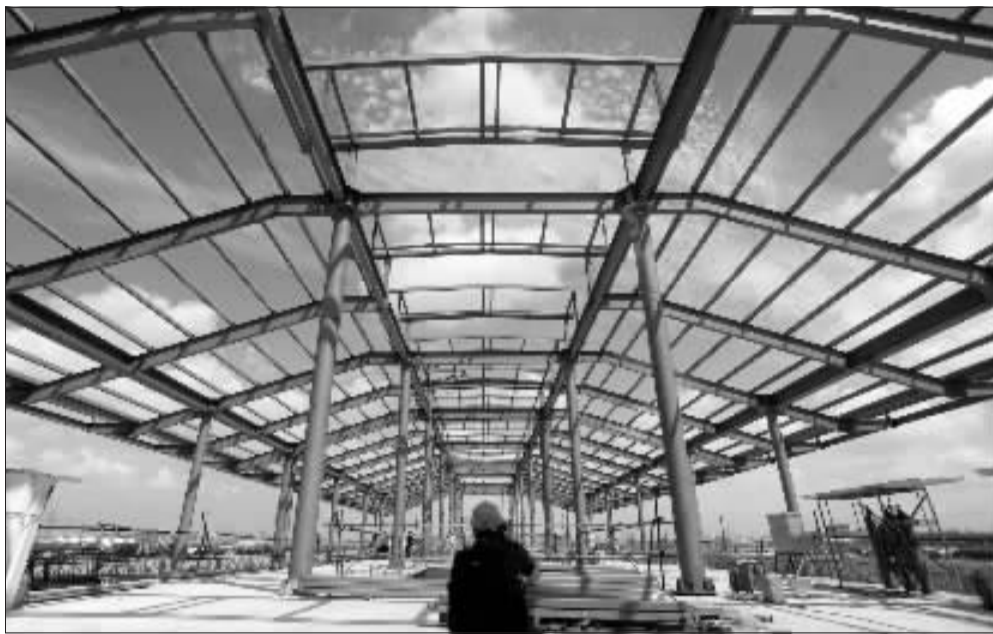
11号线罗山路站结构封顶。
